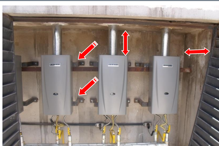
3- Suporte para afastar o chapéu da parede.
