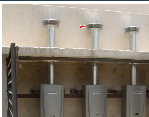
4- Chapéu com distância de 10 cm da fachada, conforme NBR13103.
